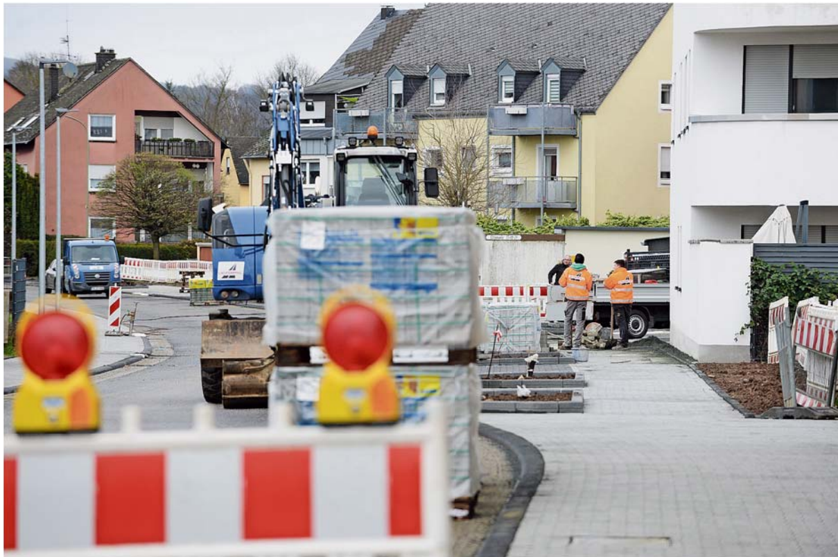
Die Baustelle in der Eltzstraße in Pfalzel schreitet voran. Die hohen Kosten für die Anlieger werden sich nach dem klaren Votum des Stadtrats deutlich verringern.
