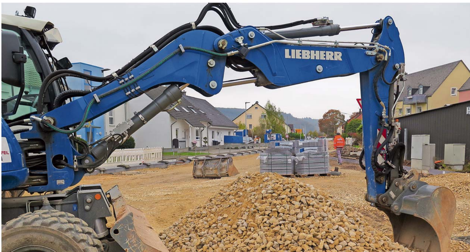
Die Sanierung der Eltzstraße in Trier-Pfalzel ist in vollem Gang. In der Diskussion über die Beiträge der Anlieger tut sich etwas.
