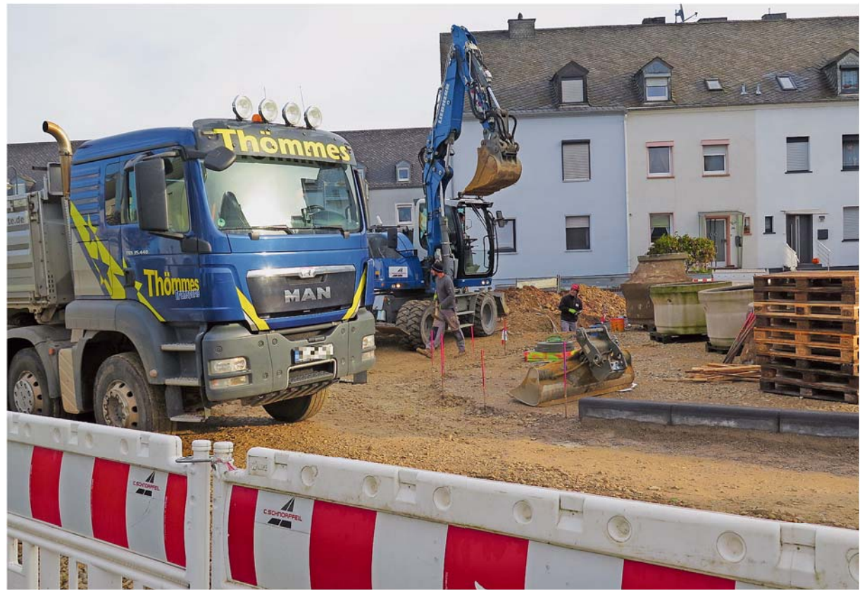
Der Ausbau der Eltzstraße in Trier (hier an der Einmündung Zur Wallmauer) schreitet voran. Ortsbeirat und Stadtrat entscheiden bald über die genaue Form der Finanzierung.
