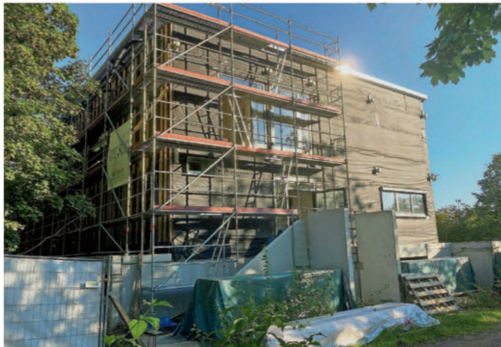
Die Kita St. Adula in Trier-Pfalzel ist weiter eine Baustelle. Es gibt jedoch einen Fertigstellungstermin.
